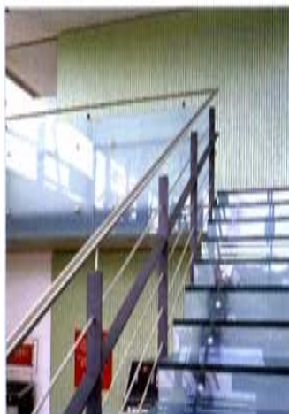
Eine individuelle Treppenlösung: Brüstung und Glastrepppe aus VSG mit hellmatter Folie. Foto: Sprinz
